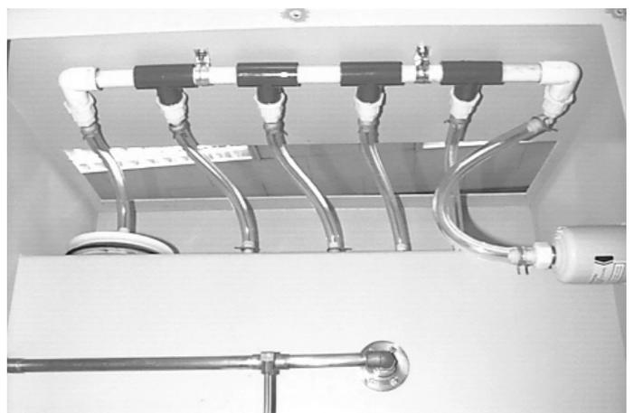
圖 5. 玻璃管上方之氣體管路詳圖 (左邊中央白色圓形為玻璃管封蓋)。
